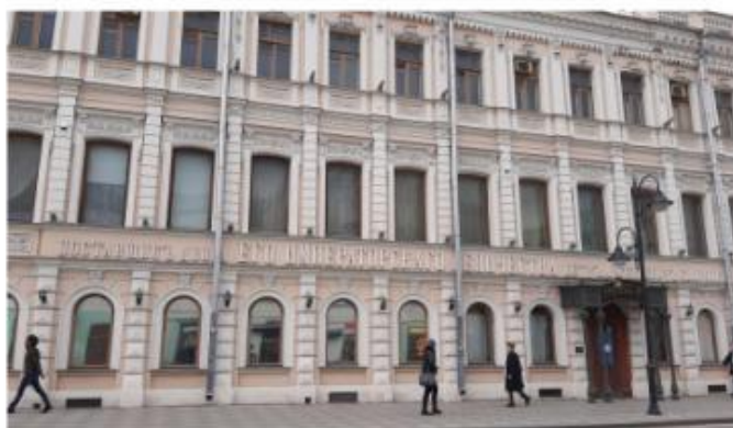
Историческая вывеска нейтрального цвета, прекрасно сочетающаяся с общей стилистикой здания, выглядит как архитектурный элемент
